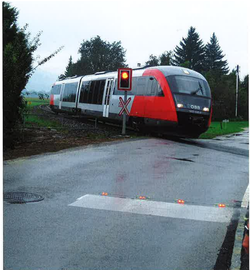
Die ISIS „Lane-Lights“ erzeugen über Bodenmarkierungsleuchten eine optische Schranke
